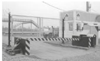
Рисунок 5. Противотаранное устройство шлагбаумного типа на объекте ТЭК
