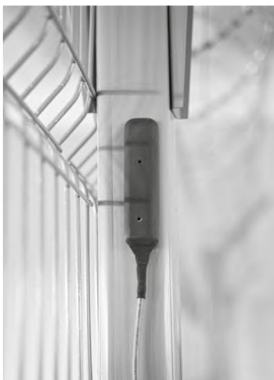
Рисунок 8г. Пример установки бескорпусной «PREPONA-U»
