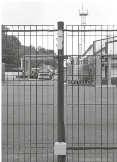
Рисунки 8б, 8в. Примеры установки ВСО «PREPONA-U» на объектах
