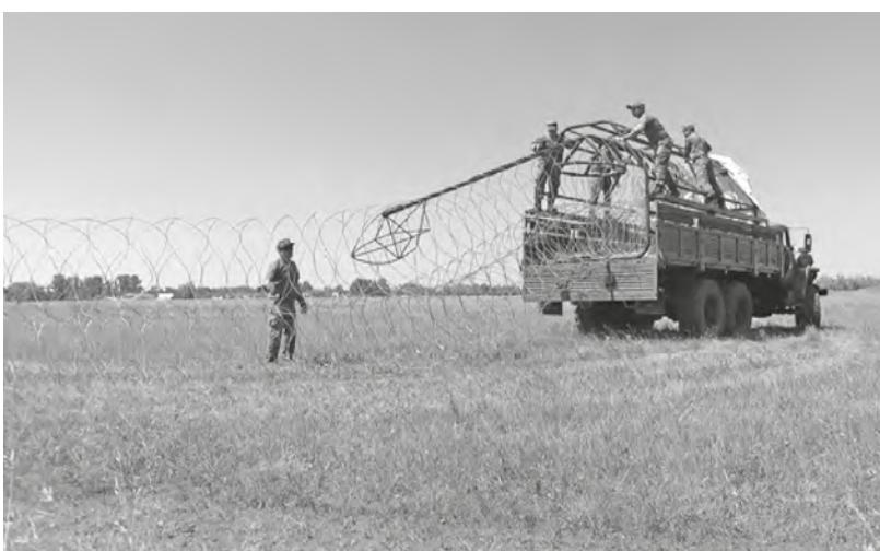
Рисунок 13. Начало процесса свертывания АКЛ БРЗ
