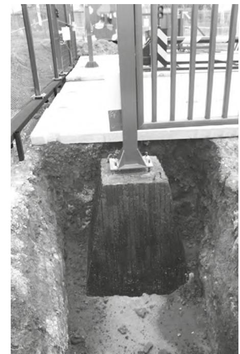
Использование готового фундамента упрощает технологию монтажа, улучшает его качество и сокращает время. К примеру, можно за один день поставить ворота, при этом не опасаясь осадков, оседания грунта и разрыва периметра охраны. Несмотря на транспортные расходы на доставку фундаментных блоков на объект, такое решение получается экономически выгодным, поскольку уменьшается не только время монтажа, но и количество участников в нем лиц.
