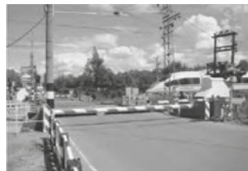
Рисунок 6. Противотаранное устройство шлагбаумного типа на железнодорожном переезде
