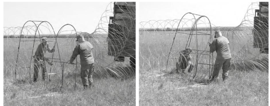
Рисунок 7а, 7б. Соединение рамки разворачиваемого БРЗ с ответной рамкой ранее развернутого заграждения
