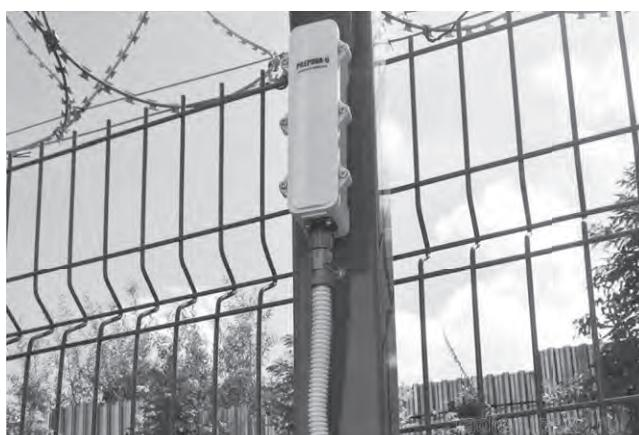
Рисунок 8а. Пример установки ВСО «PREPONA-U» на объектах
