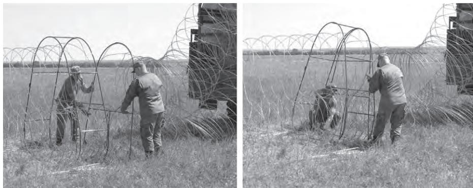
Рисунок 7а, 7б. Соединение рамки разворачиваемого БРЗ с ответной рамкой ранее развернутого заграждения
