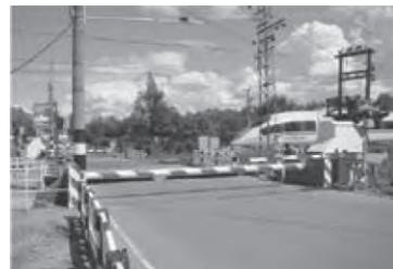
Рисунок 6. Противотаранное устройство шлагбаумного типа на железнодорожном переезде
